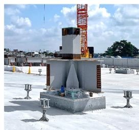
図5 免震据付状況
