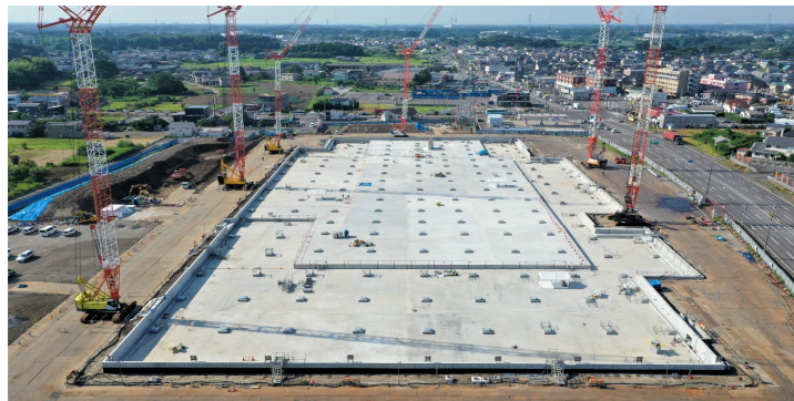
図1 免震工事全景
