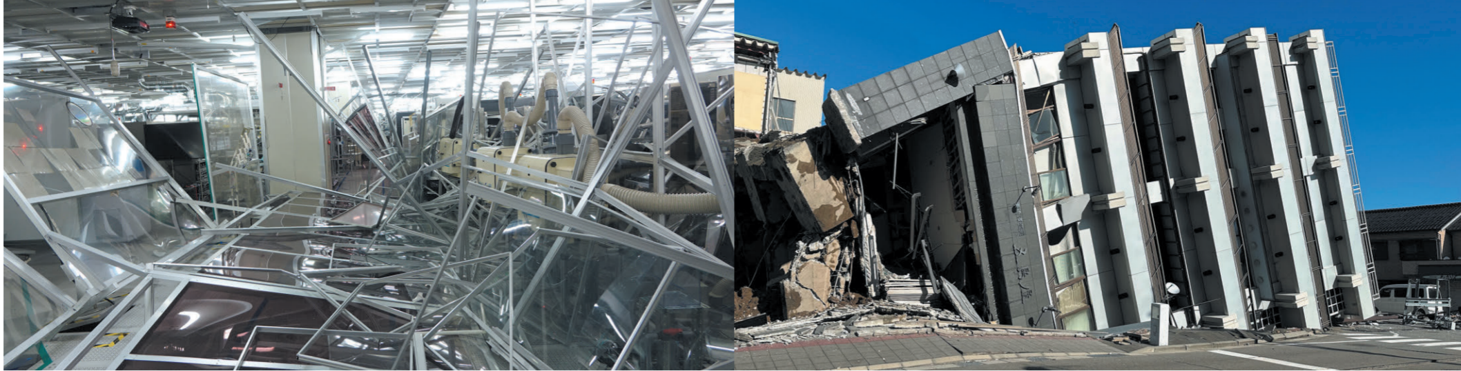
2016年4月16日発生した熊本地震で被災したソニーセミコンダクタマニュファクチャリング熊本テクノロジーセンター半導体工場
