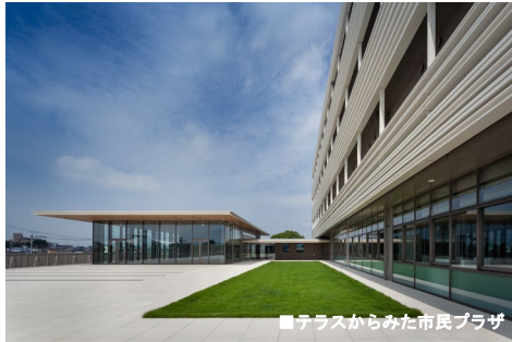
■テラスからみた市民プラザ
